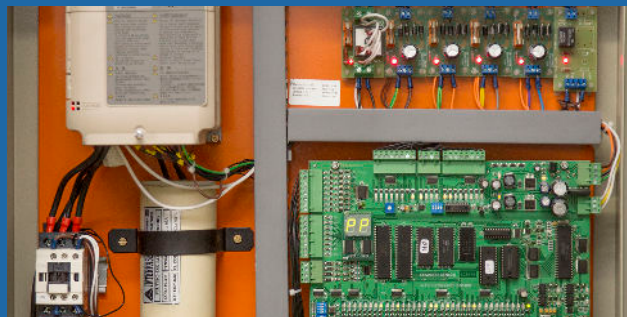
Limpeza do quadro de comando
